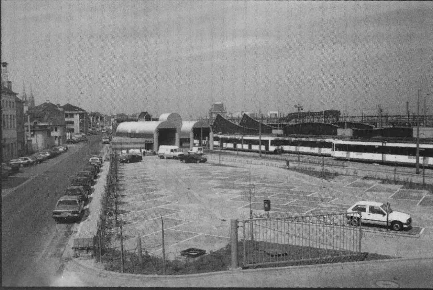
Tramwasinstallatie van De Lijn
