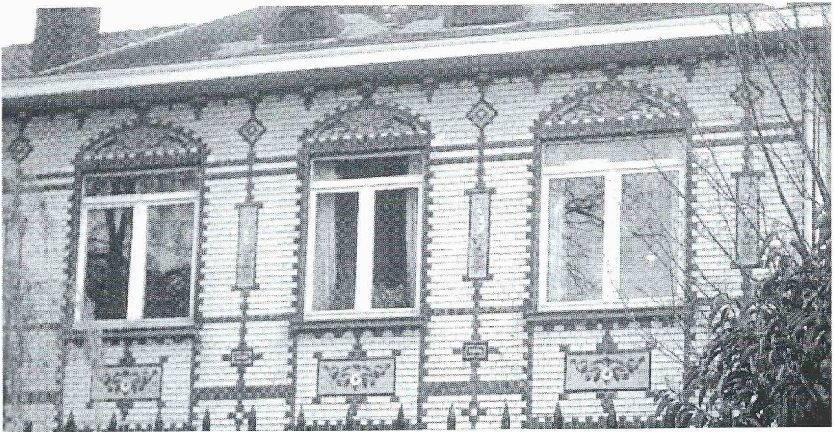
't Kasteel in Zandvoorde
