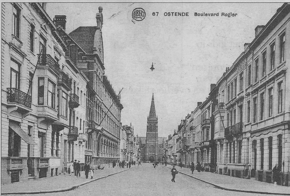
Het Koninklijk Atheneum in de Rogierlaan, richting Sint-Jozefskerk. Het naastgelegen witte huis zal worden afgebroken.
