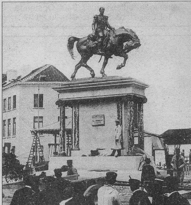
Het voetstuk met vorst en paard worden aangebracht op het Gemeenteplein, het huidige Leopold I-plein.
