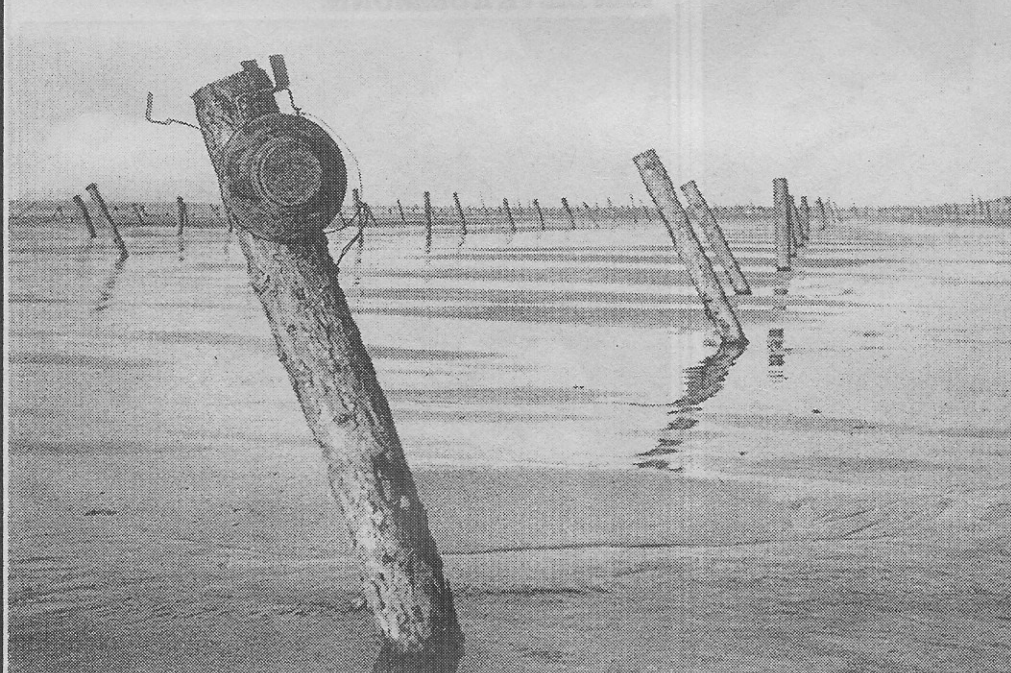
Balken ingegraven nabij de vloedlijn. Aan sommige palen werd ook een landmijn bevestigd.
