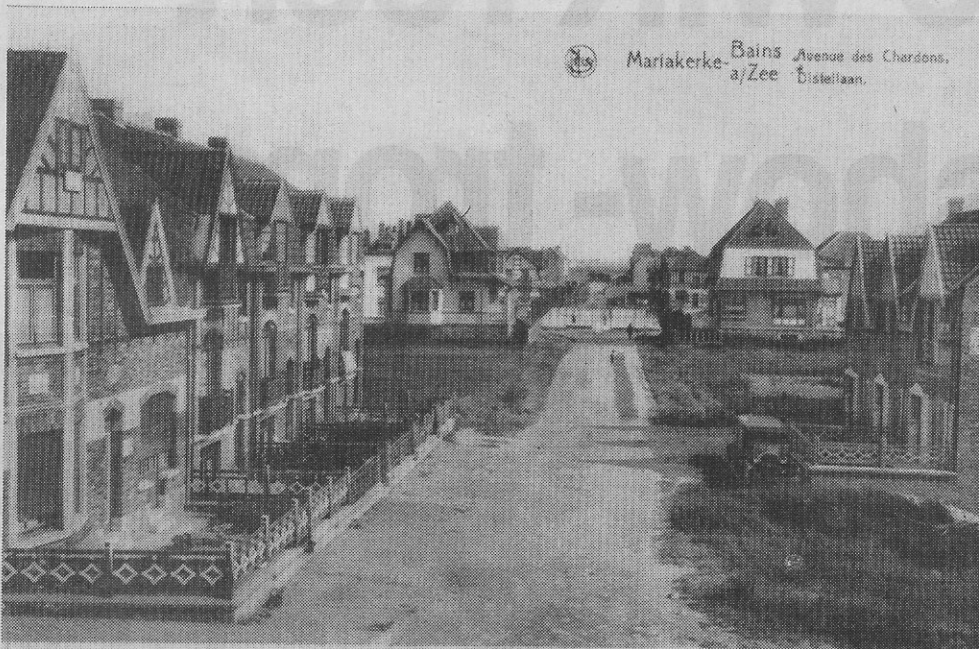
De Distellaan in volle aanleg in de dertiger jaren.
