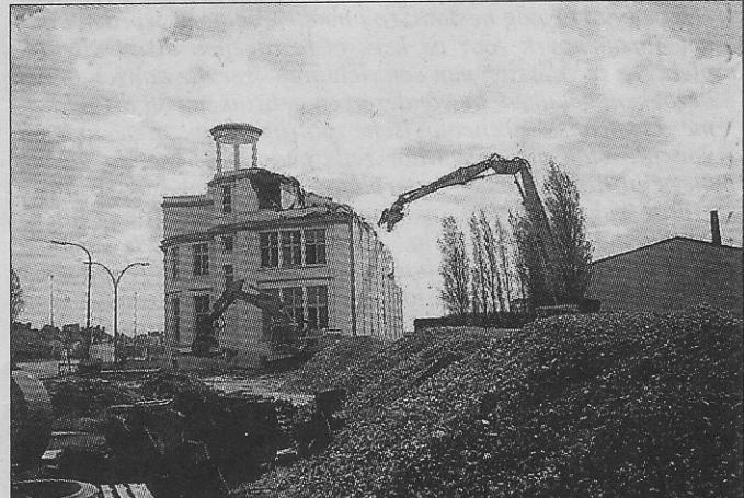
Een van de laatste afbraken : de Bolle eind april 2000.
