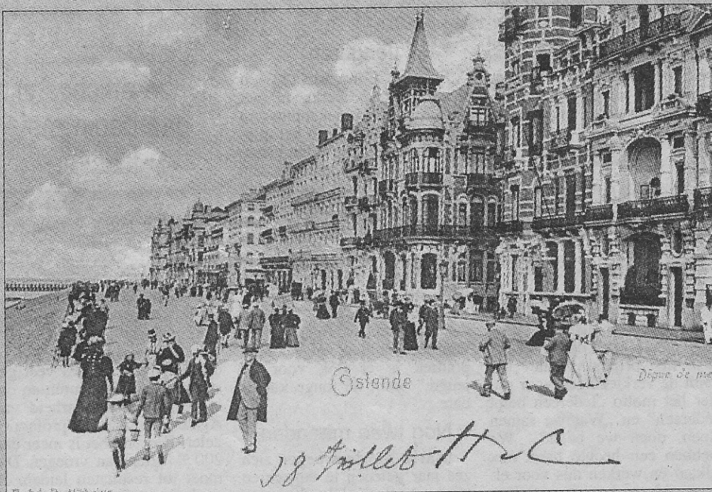
Een zicht uit het jaar 1900. Op de Zeedijk flaneerden de wandelaars, aan de ene kant genietend van de zee en aan de andere kant de mooie gebouwen bewonderend.
