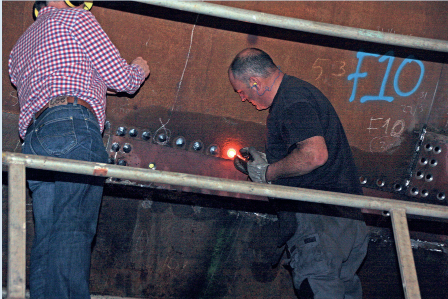
▼ Een smid uit Ichtegem klinkt de nagel vast met een pneumatische hamer. (10 mei 2016).
