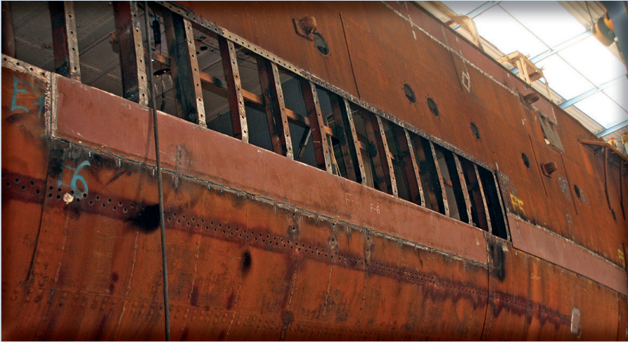
▼ Plaatsing nieuwe huidplaten van 12 mm dik. (8 april 2016).
