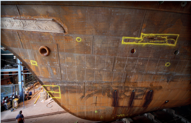
▼ Boeg bakboordkant, ook zijn de gemarkeerde spanten duidelijk zichtbaar (13 januari 2016).
