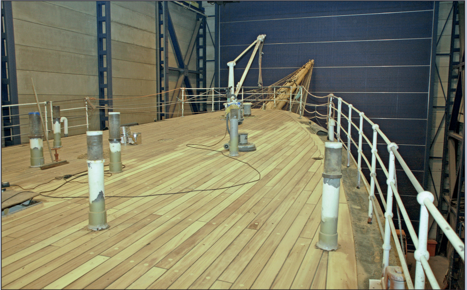
De dekplanken op het bakdek zijn gedeeltelijk afgeschuurd. (2 december 2016)
