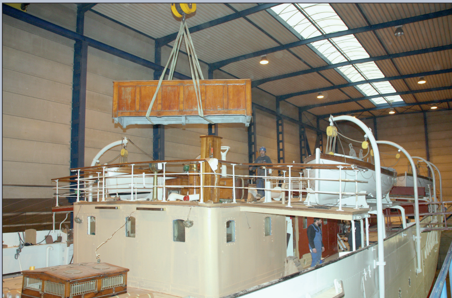
Na de reddingsboten worden o.a. de omkastingen van de friswater-tanks geplaatst op het brugdek. (1 februari 2017)
