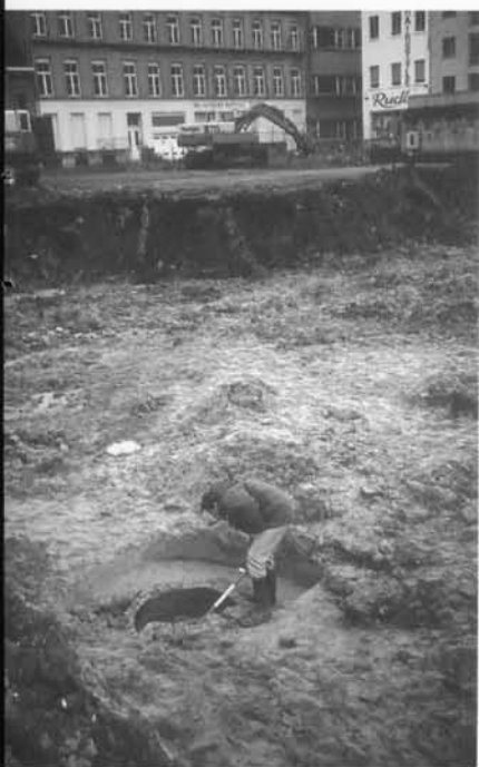
Het ledigen van een waterput...
