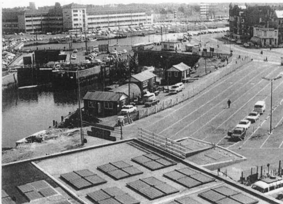
Fig. nr. 74. Haven van Oostende, 1971. Zicht op de sluis van de handelsdokken, (1e en 2e, het 3 e was reeds in 1946/1947 gedempt) en het uiteinde van de Visserskreek. Op de voorgrond het dak van het carferrystation. Op de oever van de kreek, de voormalige "Visserskaey" staan bouwketen van de aannemer van de waterbouwkundige werken voor de bouw van carferrybrug nr. 2. In de achtergrond de stedelijke technische school en rechts het "Waterhuis".
