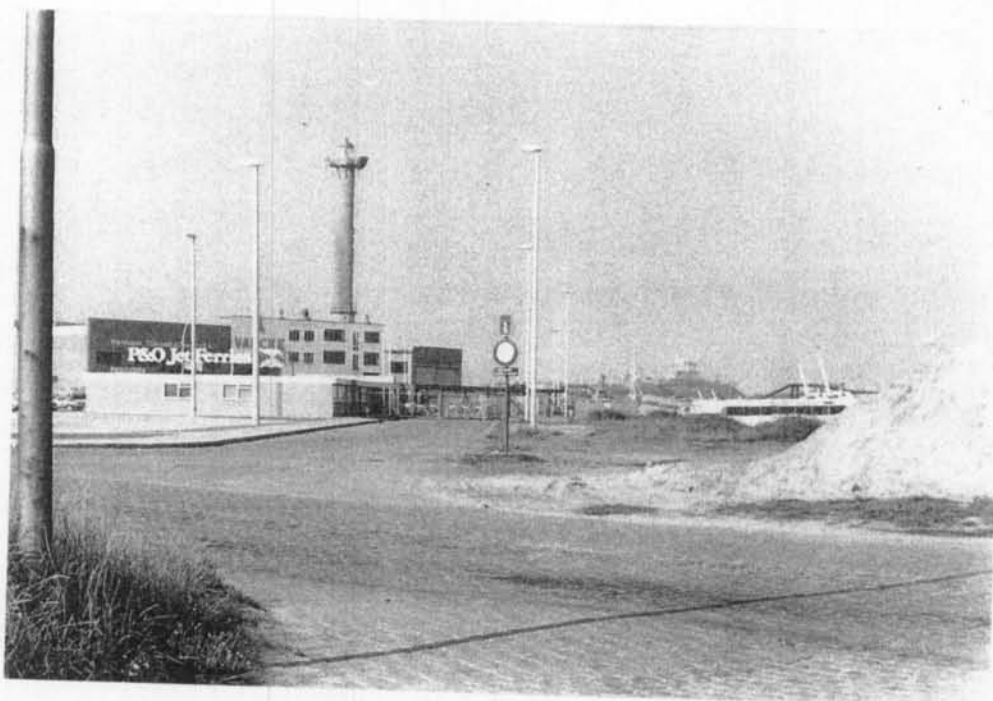
Fig. nr. 71. Haven Oostende, 1980. De P&O JetFerries terminal aan het Vuurtorendok , (Vuurtorendok-Zuid, aanpalend aan de Fortstraat)
