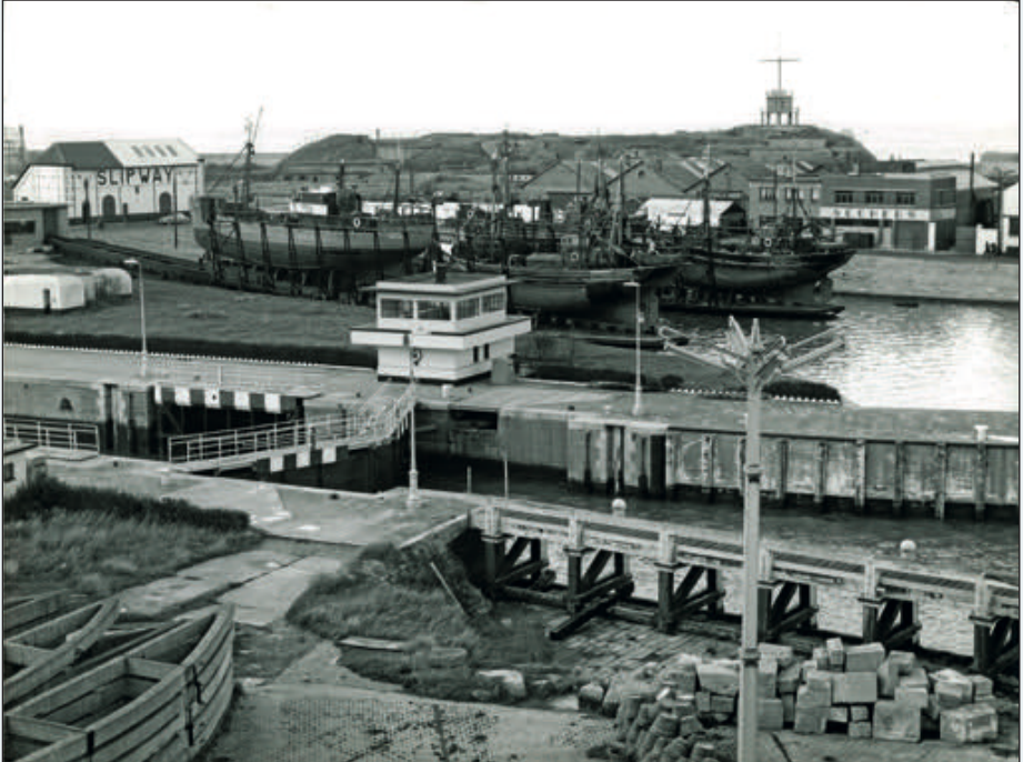
Zicht op sas 'Visserijdok' en de slipway , gezien vanop het dak van het bestuursgebouw Vismijn. Achteraan de scheepswerf Seghers (Slipwaykaai) en het militair domein "Halve Maan".
